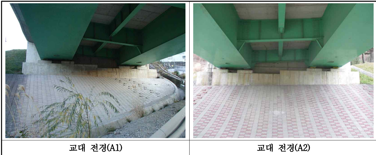
【사진 3.3.7】 교대 전경(부산)
