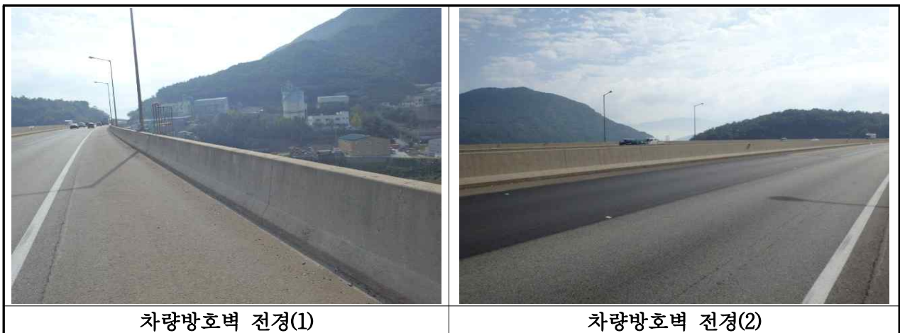
【사진 3.3.20】 방호벽 전경(부산)
