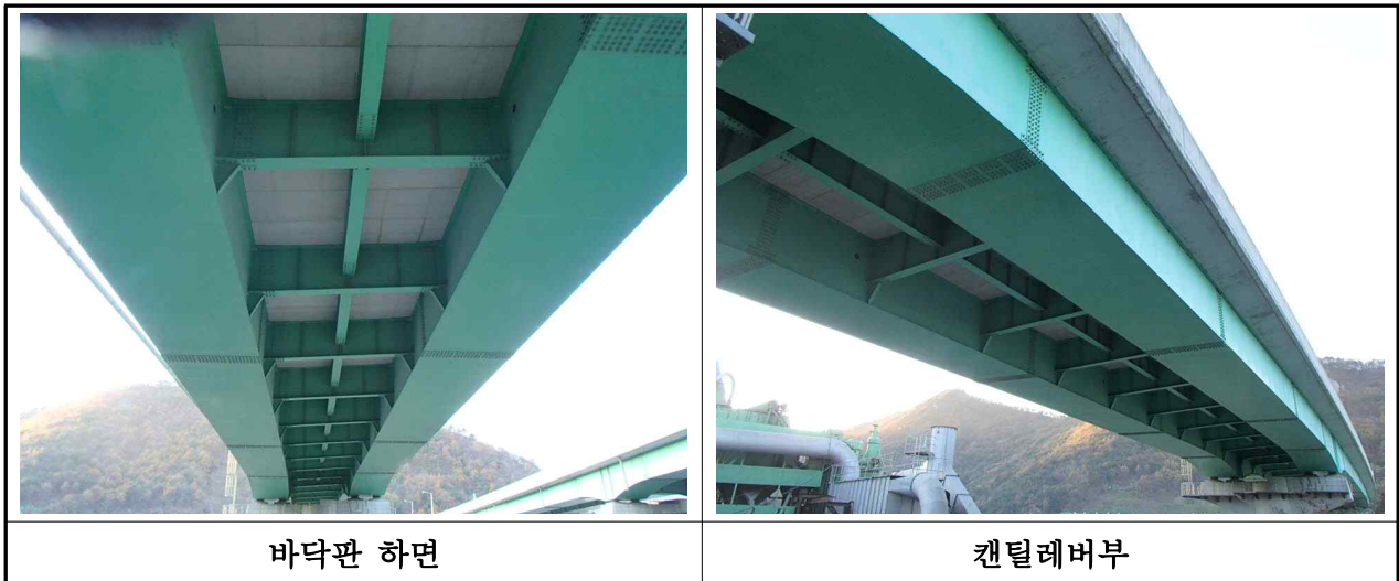
【사진 3.2.1】 바닥판 전경(대구)
