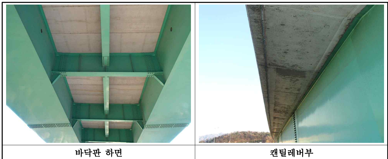
【사진 3.3.1】 바닥판 전경(부산)
