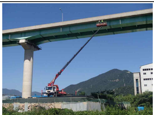
고소점검차를 이용한 조사
