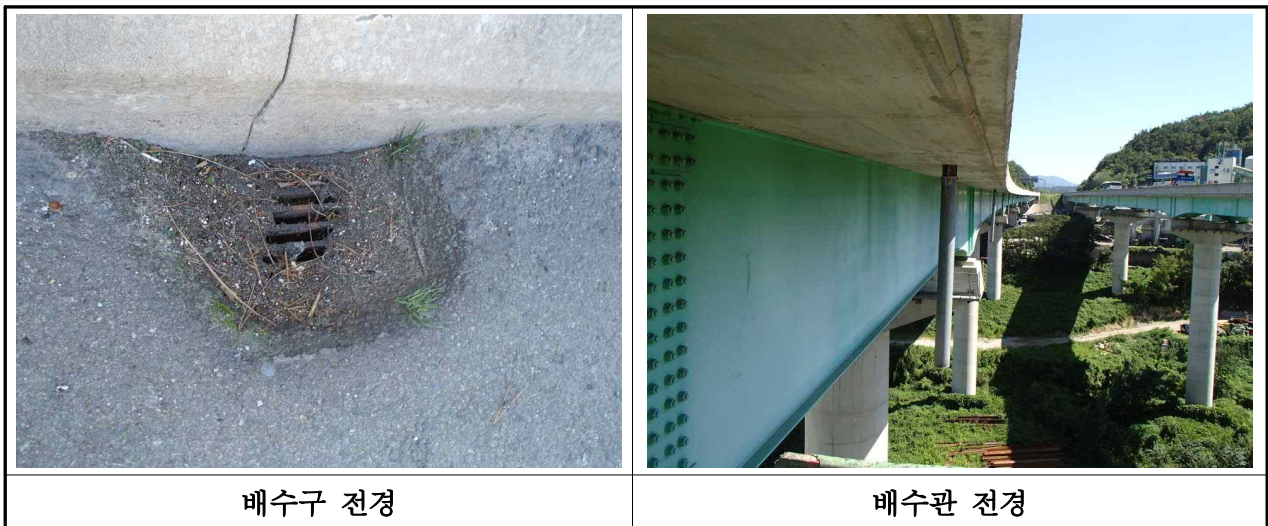
【사진 3.2.18】 배수구 및 배수관 전경(대구)
