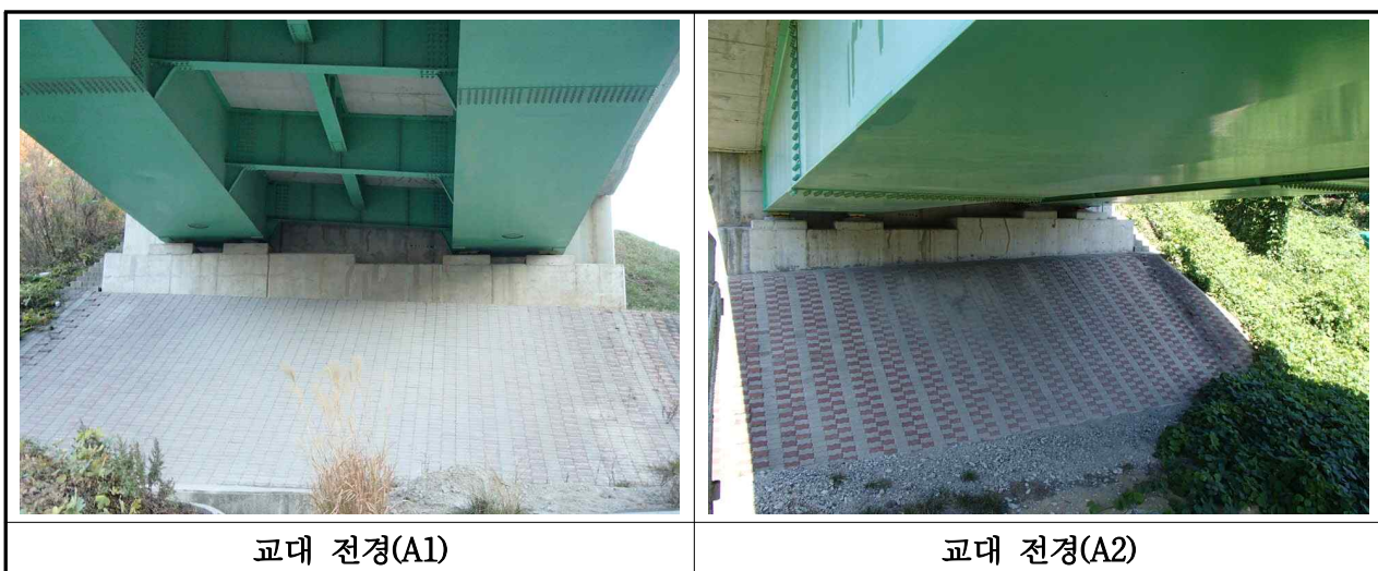
【사진 3.2.7】 교대 전경(대구)
