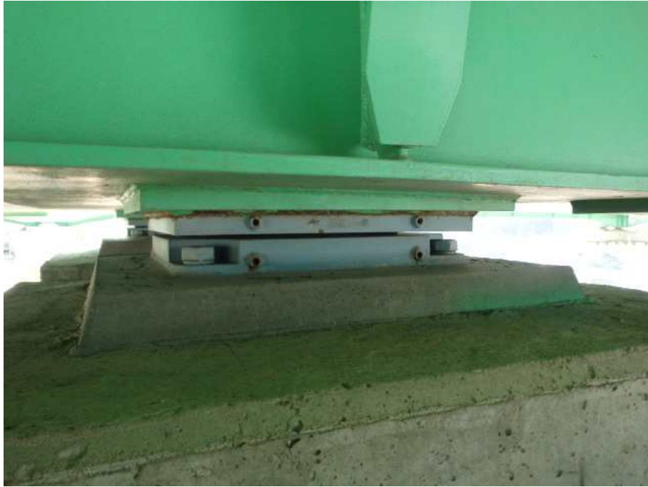
받침장치 전경 (고정단)
