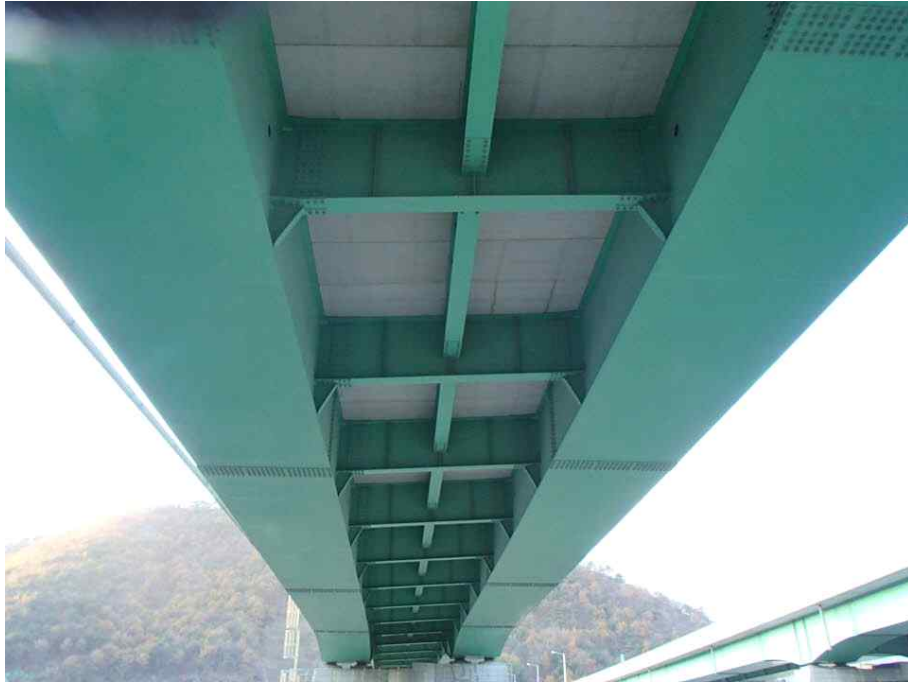
Steel Box Girder 외부 전경
