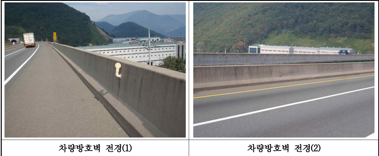
【사진 3.2.20】 방호벽 전경(대구)
