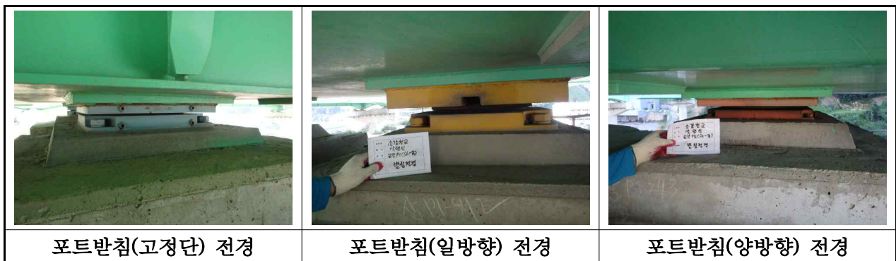
【사진 3.2.11】 교량받침 전경(대구)
