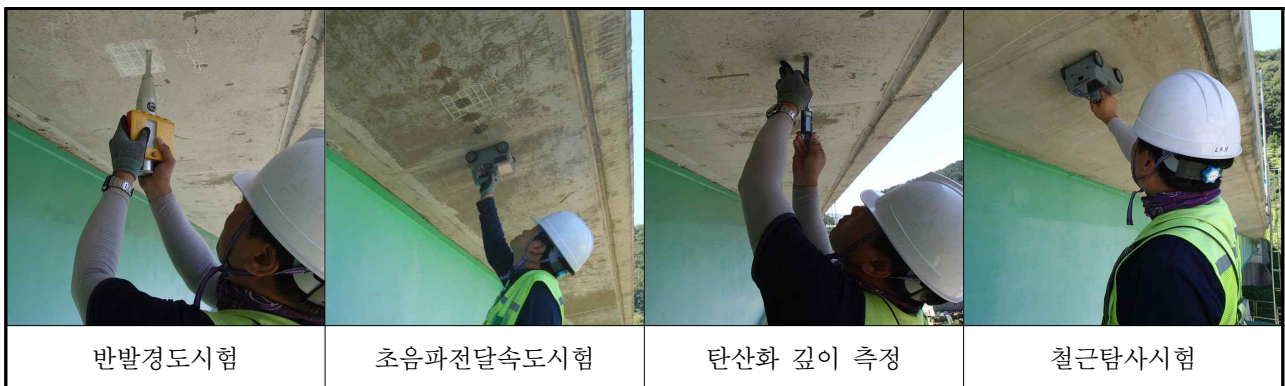
【사진 3.4.1】콘크리트 내구성조사 전경
