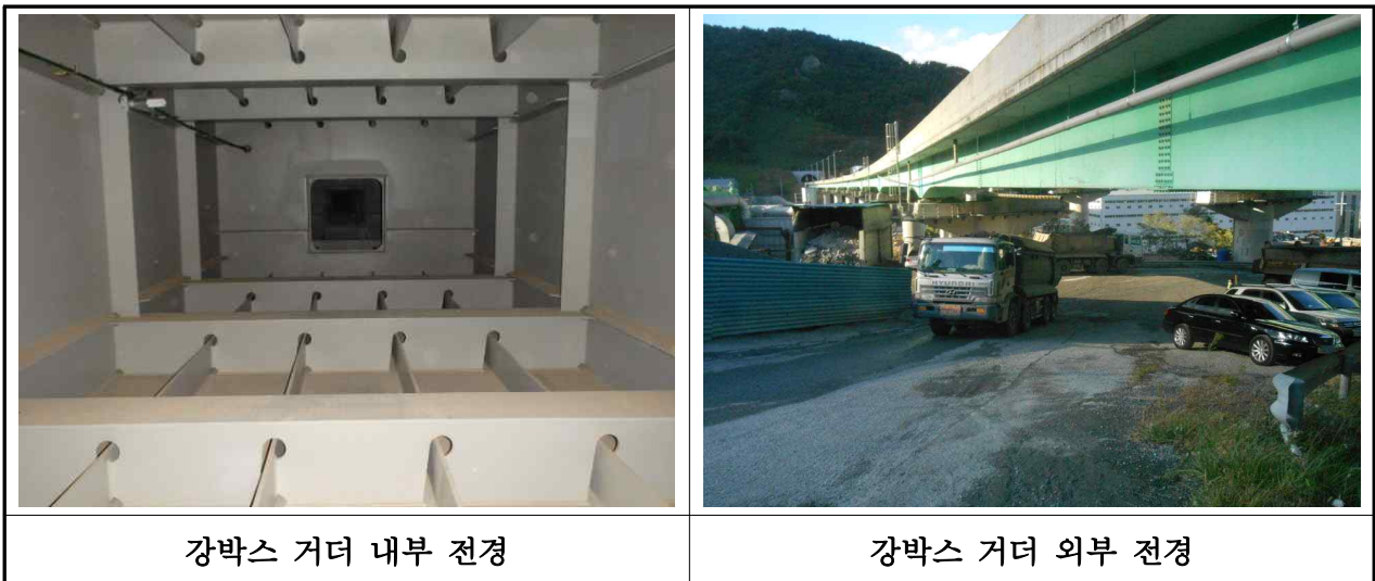
【사진 3.3.3】 강박스 거더 전경(부산)
