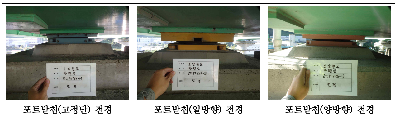
【사진 3.3.11】 교량받침 전경(부산)
