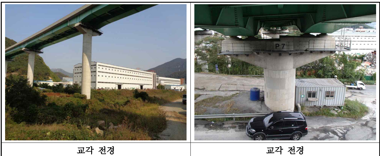
【사진 3.2.9】 교각 전경(대구)
