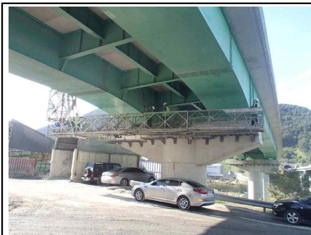
교량점검차를 이용한 조사
